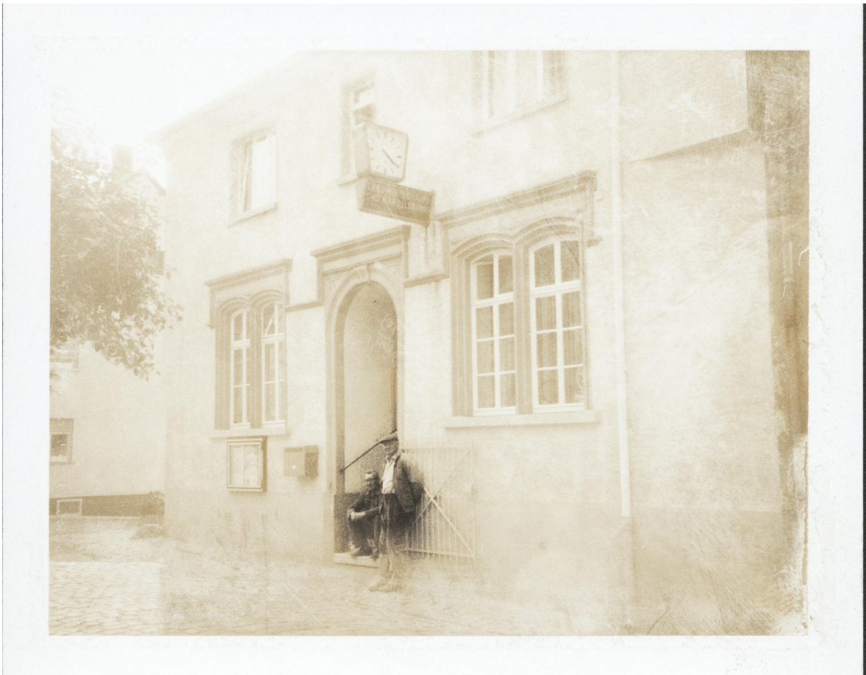
Das alte Posthaus Breite Gasse 7 - Vergleiche Seite 2 – das Haus wurde aufgestockt.
